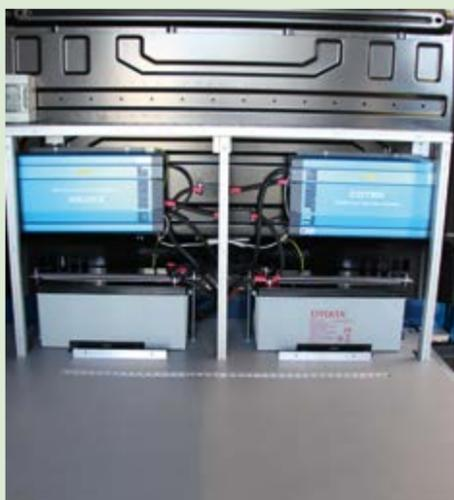
12 V/230 V Spannungswandler 2 x 3000 W mit 2 x Zusatzbatterie
